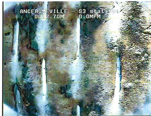
Craie blanche occultant le massif de gravier filtre
