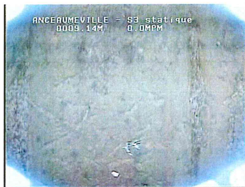
Tube lisse avec incrustation régulière et modérée
