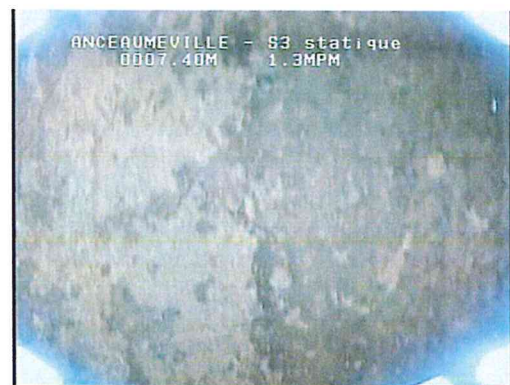
Tube lisse avec incrustation régulière et modérée
