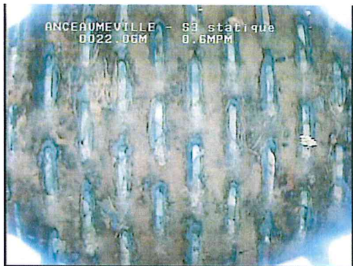
Incrustation d'hydroxyde de fer de plus en plus dense pour se généraliser sur toute la crépine, colmatage partiel des ouvertures par ces mêmes dépôts ferriques plus ou moins indurés
