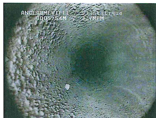
Tube lisse avec incrustation régulière et modérée
