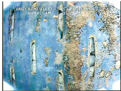
Incrustation hétérogène (zones de la crépine « intègres ») d'hydroxyde de fer avec adhérences de colloïdes (flocs bactériens). Fentes dégagées laissant entrevoir à l'extrados le massif de gravier filtre homogène et « intègre »
