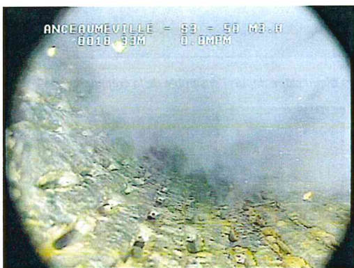
Colonne d'eau « centrale » chargée en turbidité avec venues d'eau claire depuis l'ensemble de la crépine
