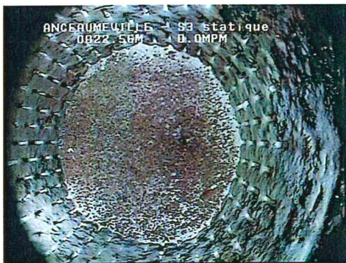
Vue d'ensemble du fond et de la base de la partie crépinée
