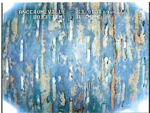
Incrustation hétérogène (zones de la crépine « intègres ») d'hydroxyde de fer avec adhérences de colloïdes (flocs bactériens). Fentes dégagées laissant entrevoir à l'extrados le massif de gravier filtre homogène et « intègre »
