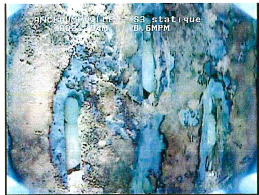
Détail du concrétionnement d'hydroxyde de fer et des adhérences colloïdales qui le recouvre
