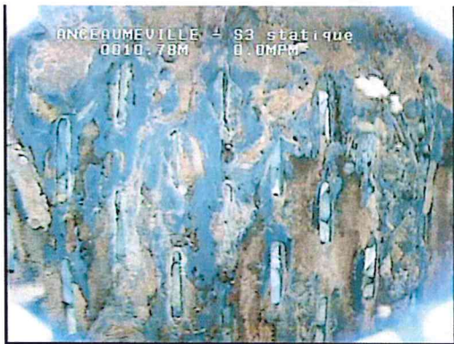
Incrustation hétérogène (zones de la crépine « intègres ») d'hydroxyde de fer avec adhérences de colloïdes (floccs bactériens). Fentes dégagées laissant entrevoir à l'extrados le massif de gravier filtre homogène et « intègre »
