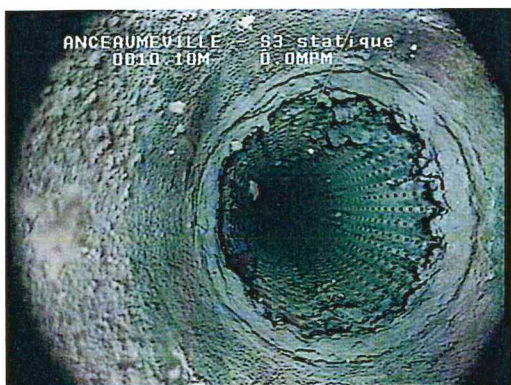
Vue d'ensemble de la base du tube lisse et du sommet de la partie crépinée
