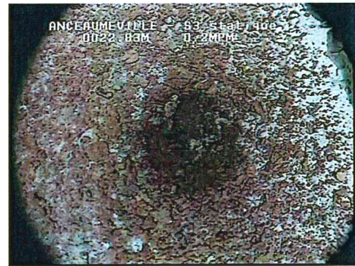
Détail du fond composé de craie et recouvert de débris de concrétions
