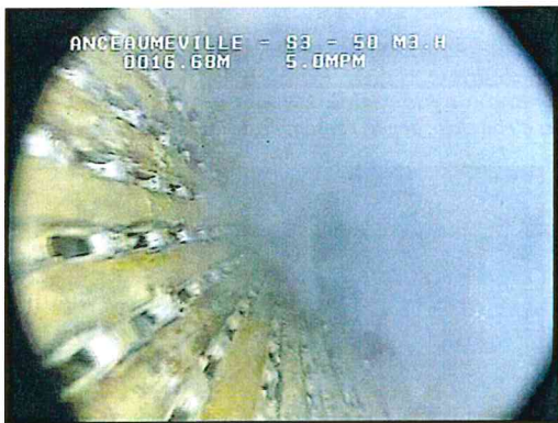
Colonne d'eau « centrale » chargée en turbidité avec venues d'eau claire depuis l'ensemble de la crépine
