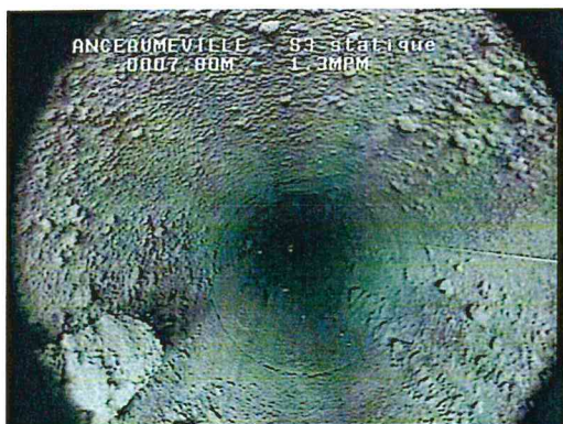
Tube lisse avec incrustation régulière et modérée, rares concrétions isolées plus volumineuses
