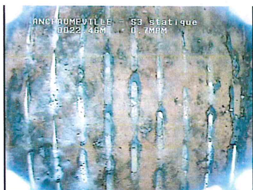
Incrustation généralisée sur la crépine avec craie de plus en plus dense à l'extrados occultant tout ou partie du gravier filtre
