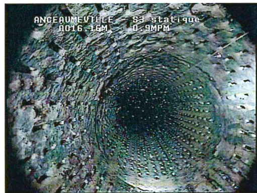
Incrustation hétérogène (zones de la crépine « intègres ») d'hydroxyde de fer avec adhérences de colloïdes (flocs bactériens). Fentes dégagées laissant entrevoir à l'extrados le massif de gravier filtre homogène et « intègre »
