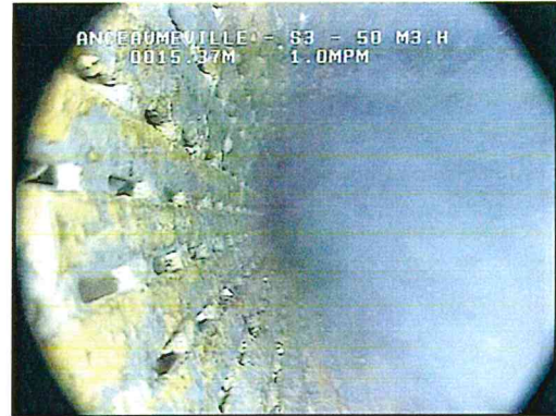
Colonne d'eau « centrale » chargée en turbidité avec venues d'eau claire depuis l'ensemble de la crépine
