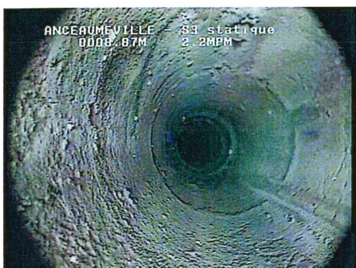
Tube lisse avec incrustation régulière et modérée
