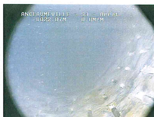
Arrivées d'eau (EN STATIQUE) avec venues de particules de craie au travers de certaines fentes
