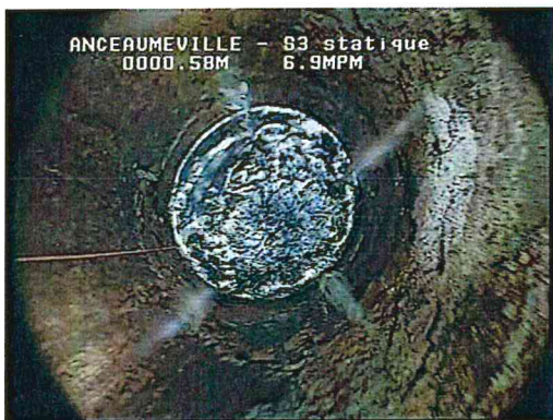
Tube lisse hors eau avec corrosion plus prononcée engendrant un effeuillement du casing
