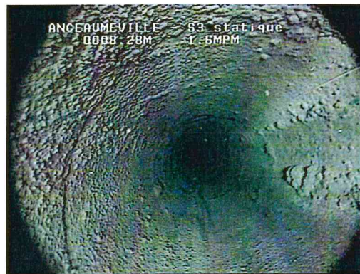
Tube lisse avec incrustation régulière et modérée, rares concrétions isolées plus volumineuses
