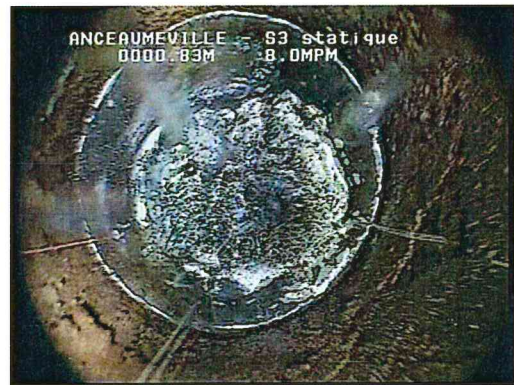
Tube lisse hors eau avec corrosion plus prononcée engendrant un effeuillement du casing
