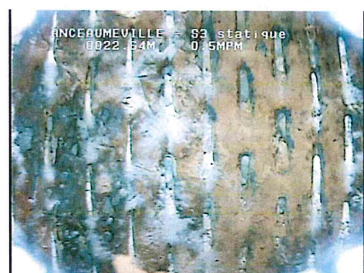
Incrustation généralisée sur la crépine avec craie de plus en plus dense à l'extrados occultant tout ou partie du gravier filtre
