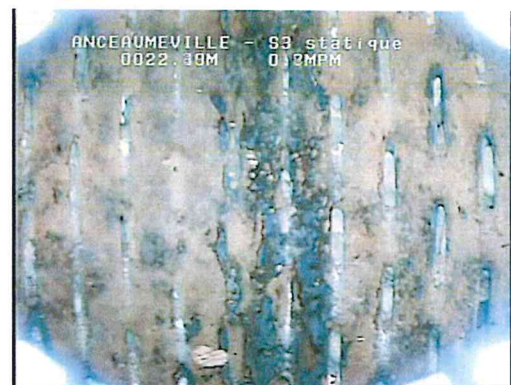
Incrustation d'hydroxyde de fer de plus en plus dense pour se généraliser sur toute la crépine, colmatage partiel des ouvertures par ces mêmes dépôts ferriques plus ou moins indurés
