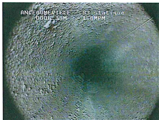
Tube lisse avec incrustation régulière et modérée
