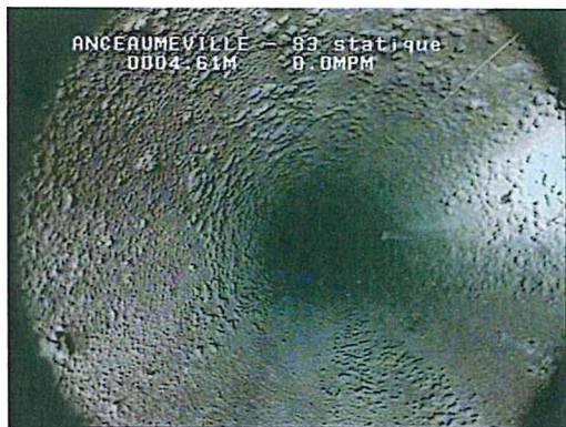
Tube lisse avec incrustation régulière et modérée
