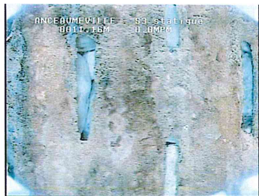
Incrustation hétérogène (zones de la crépine « intègres ») d'hydroxyde de fer avec adhérences de colloïdes (floccs bactériens). Fentes dégagées laissant entrevoir à l'extrados le massif de gravier filtre homogène et « intègre »
