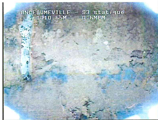
Jonction tube lisse et partie captante
